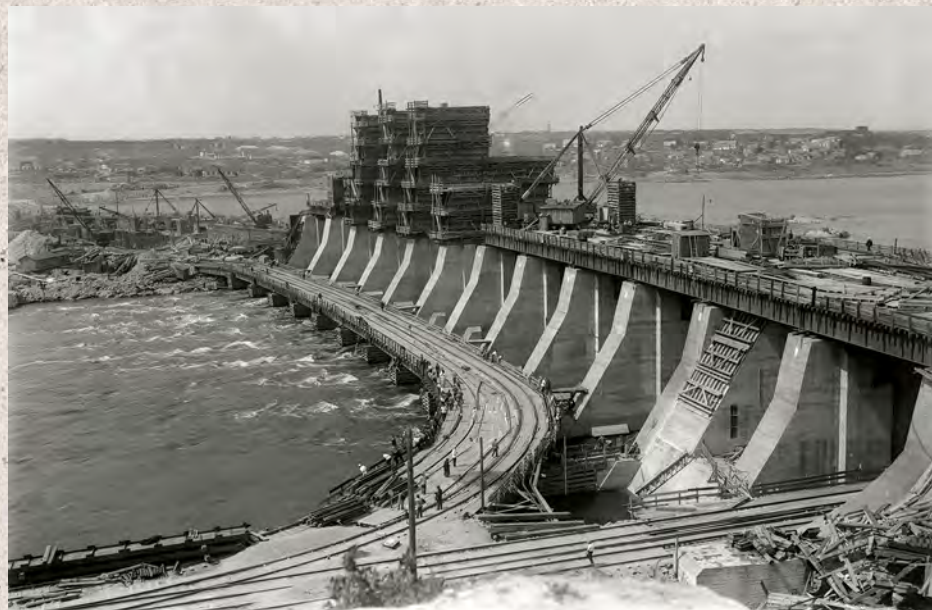
Будівництво ДніпроГЕСу, 1930 рік
